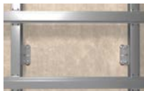
Underkonstruktion til facade
